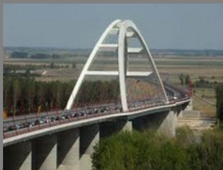
M8 Autópálya, Pentele híd, Ártéri pillérek
